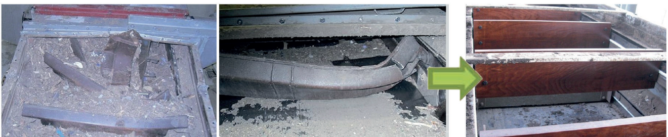
"Cuillères" excavatrices d'un transporteur de résidus de combustion
