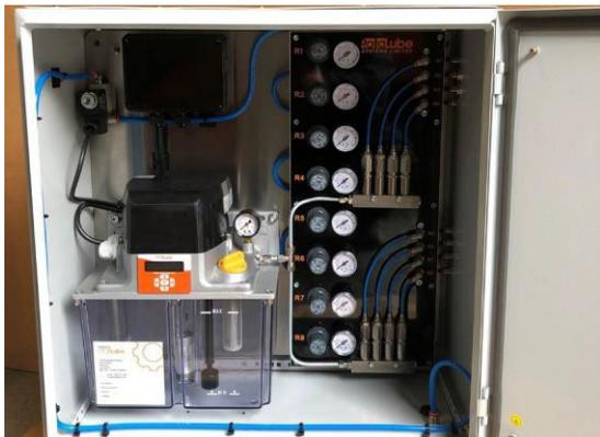
Systèmes montés dans des boîtiers en acier dotés d'un revêtement epoxy
