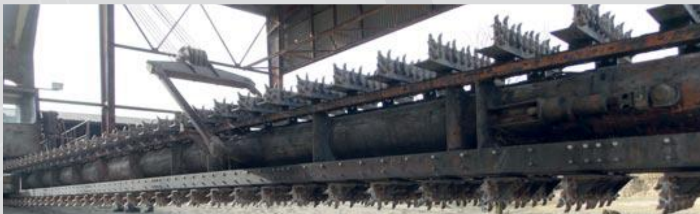
Convoyeur à racleurs pour sable laitier de haut-fourneau
