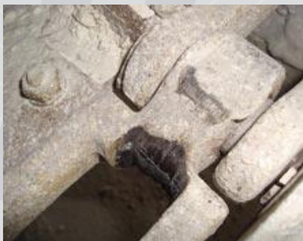
Forte usure due au pignon
